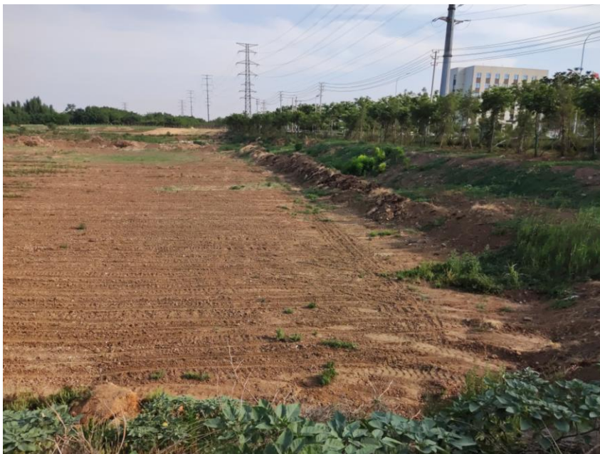
评估区照片 2（地面塌陷）
